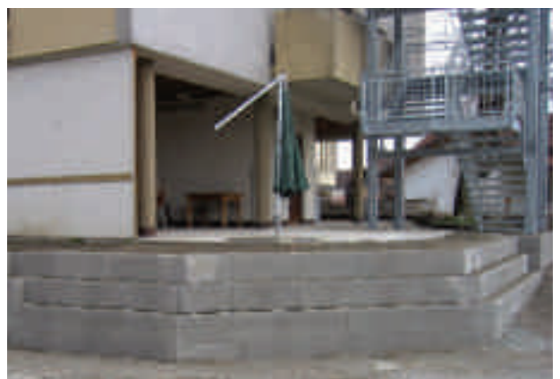
Bereits fertiggestellt ist die neue Feuertreppe (siehe auch 1. und 2. Bild von oben), die sich für Liegendtransporte eignet.
