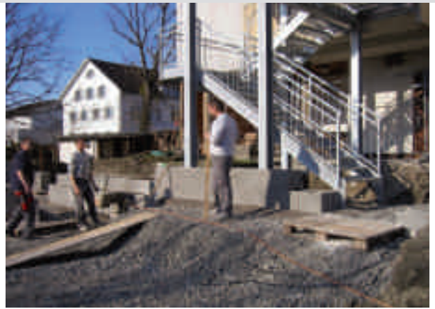
Bauarbeiten am St. Josefshaus: Die neue Feuerwehzufahrt wird angelegt, ...
