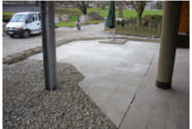
Zum Schutz der darunterliegenden Büroräume musste sie neu abgedichtet und verlegt werden.
